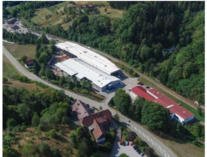
Unité 2 à Oppenau-Löcherberg (Vue aérienne)
